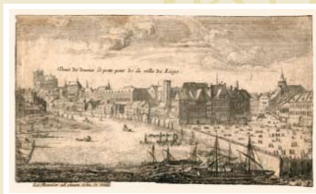
Vue du dessus le pont de la ville de Liège, par Le Meunier.
